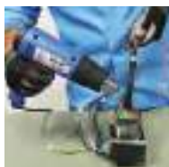
Termoencolhimento em Protetores de Cabos
